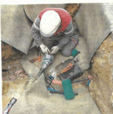
À côté de ce chantier, un autre est prévu non loin de là, rue Joséphine.
