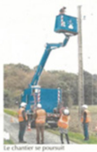
Le chantier se poursuit
